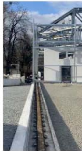
Schienen©Unger Stahlbau Ges.m.b.H..jpg
